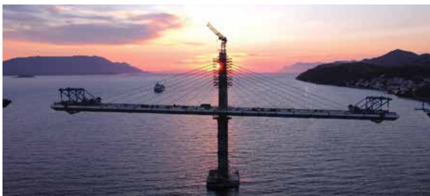
Zatege na stupovima lepezastoga su oblika. (foto: EdoStuff)
