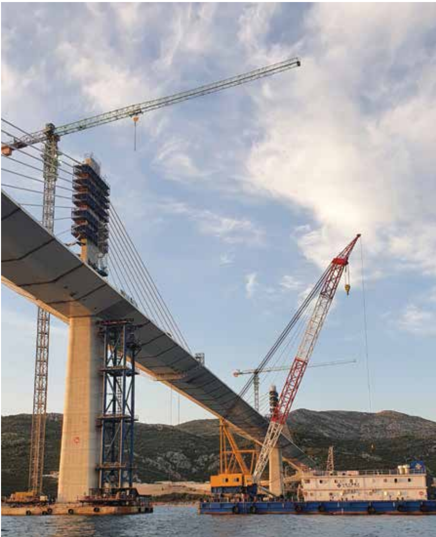
Minimalni zahtijevani plovidbeni profil ispod mosta iznosi 200 x 55 metara
