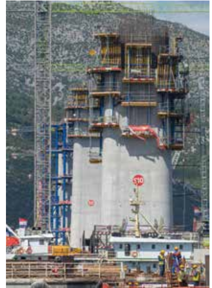
Armiranje stupova S9 i S10
