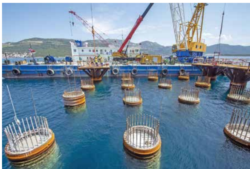
Temeljenje mosta bilo je velik izazov za inženjere (foto: CRBC)
