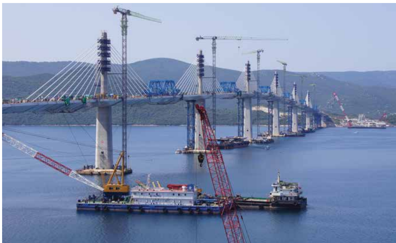
Pogled na gradilište Pelješkoga mosta, snimljeno 8. srpnja 2021.
