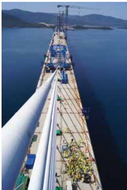
Detalj s gradilišta
