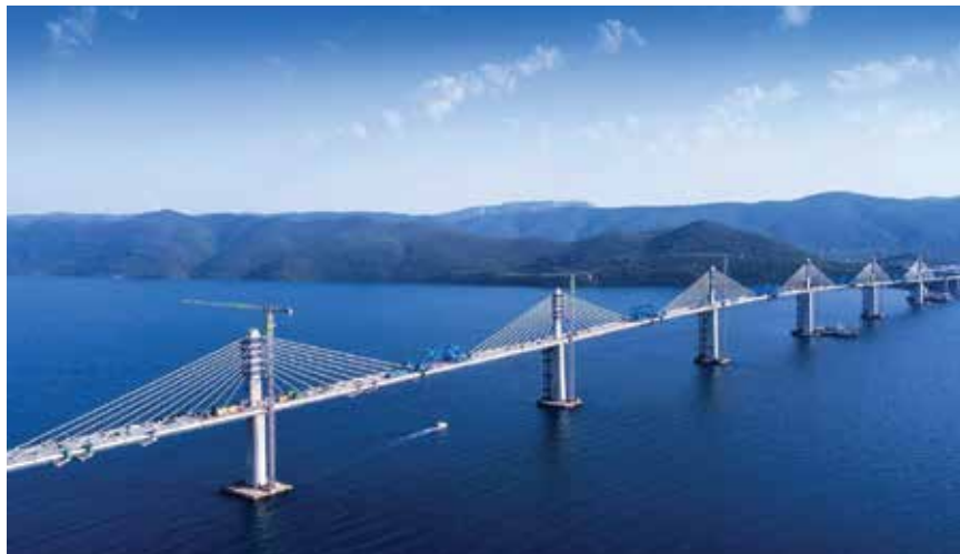
Središnji dio nosive konstrukcije ima pet glavnih otvora i šest pilona
