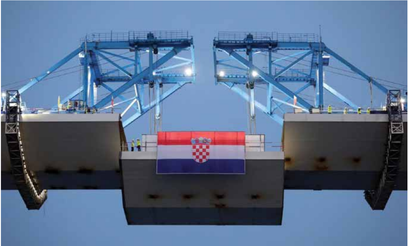
Podizanje posljednjega, 165. segmenta čelične konstrukcije
