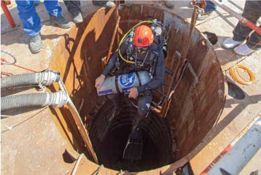
Detalj s gradilišta tijekom faze temeljenja mosta (foto: Denis Jerković / CROPIX)
