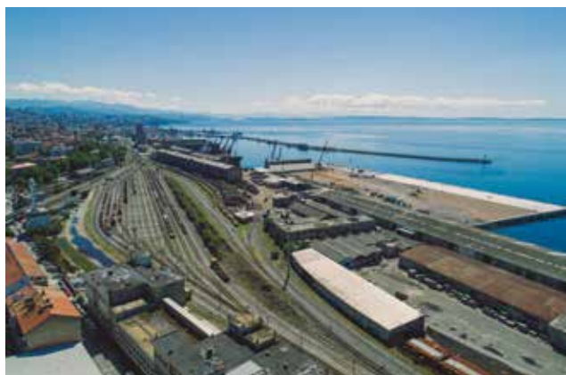
Radovi na izgradnji Zagreb Deep Sea kontejnerskog terminala, snimljeno krajem 2019.
