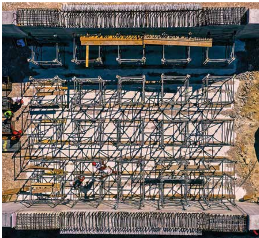
Pogled na gradilište Pelješkog mosta
