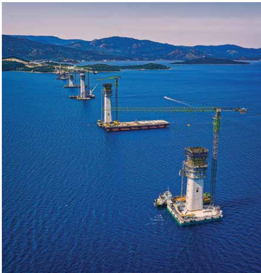
Armiranje upornjaka na Pelješkom mostu
