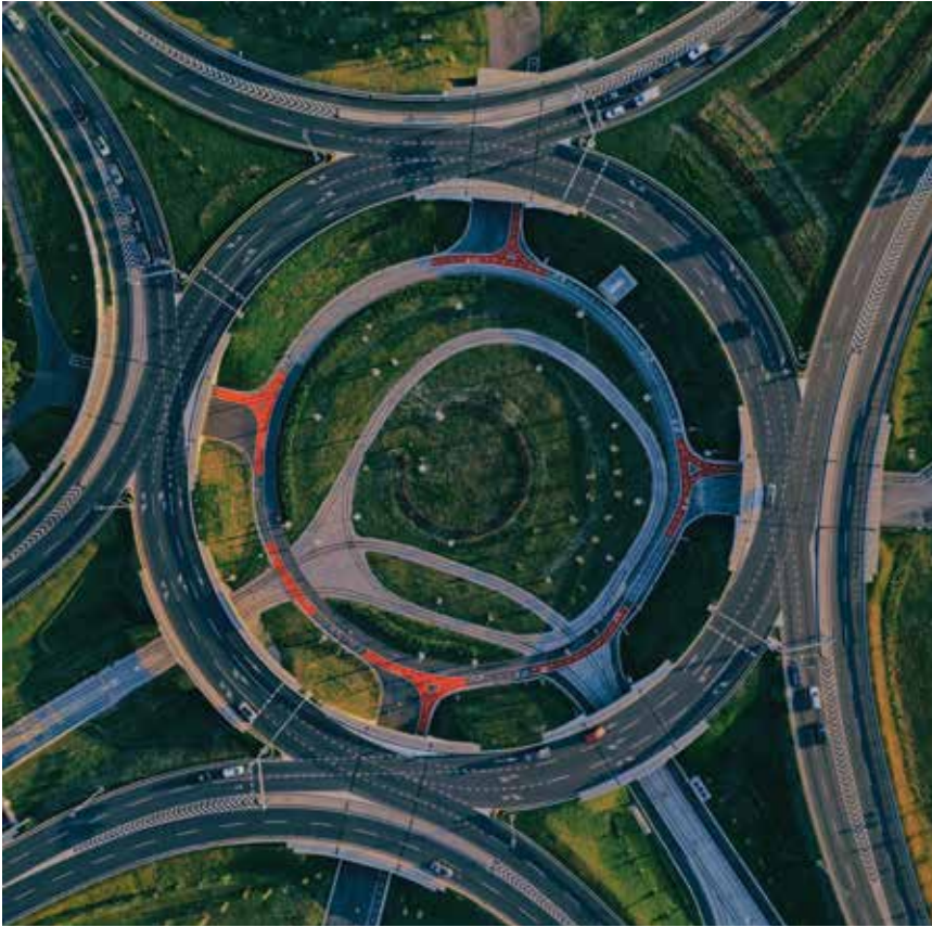
Pogled iz zraka na zagrebački rotor Remetinec
