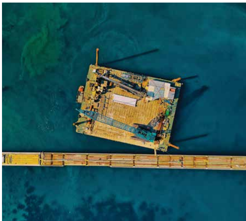
Prikaz dijela gradilišta dogradnje luke na Cresu
