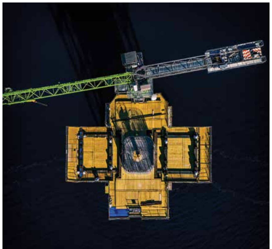
Pogled na jedan od stupova budućeg Pelješkog mosta
