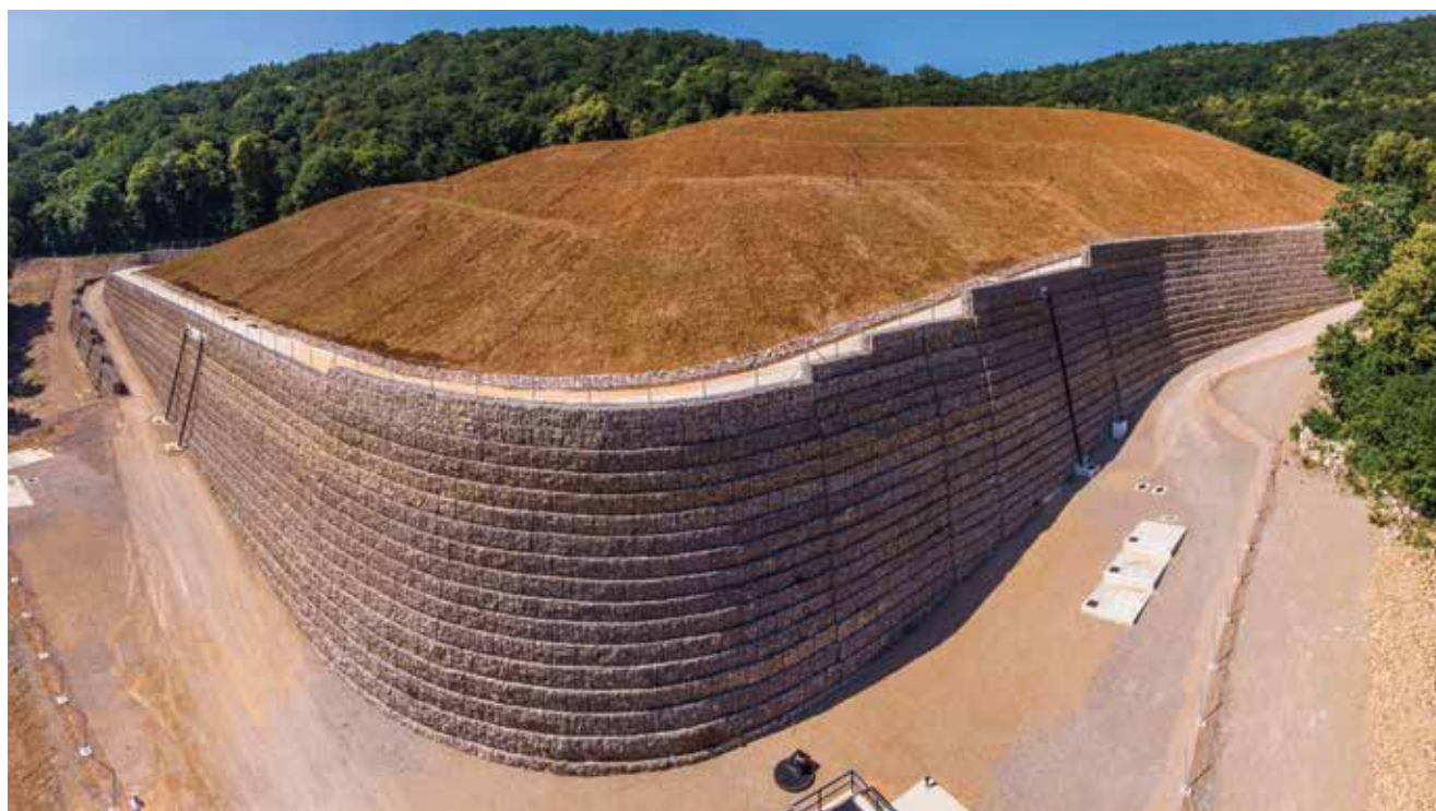
Pogled na zid od armiranog tla s gabionskom oblogom
