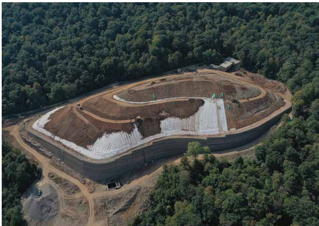
Detalj s gradilišta snimljen tijekom izvođenja radova na prekrivnom sustavu odlagališta
