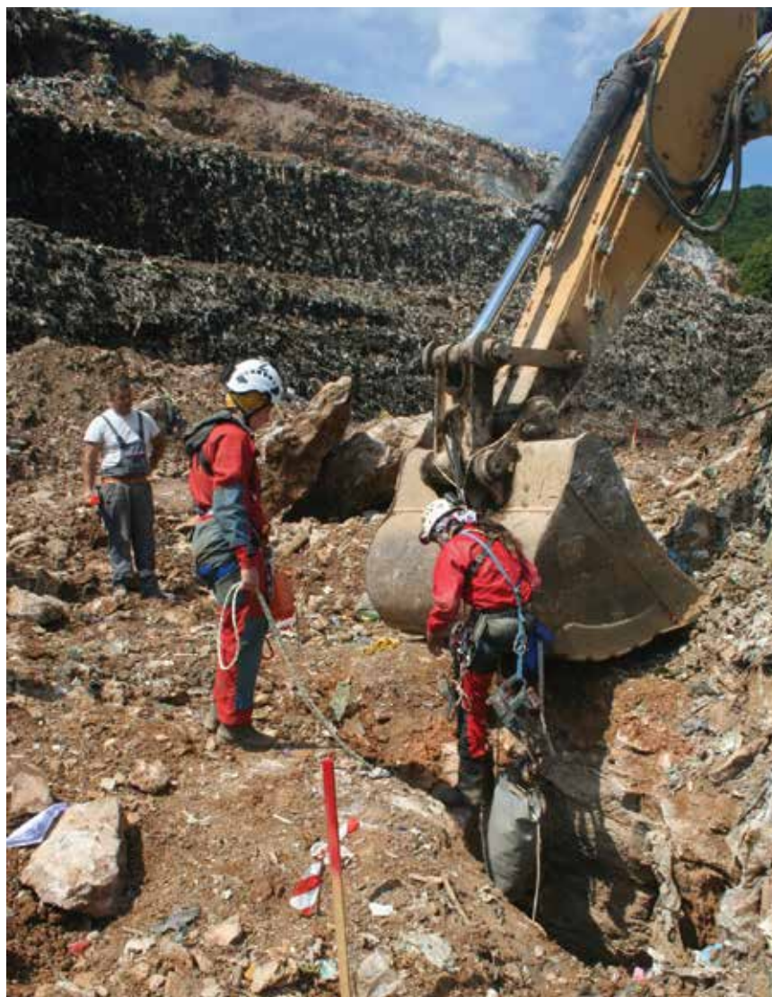
Tijekom građevinskih radova otkriven je speleološki objekt
