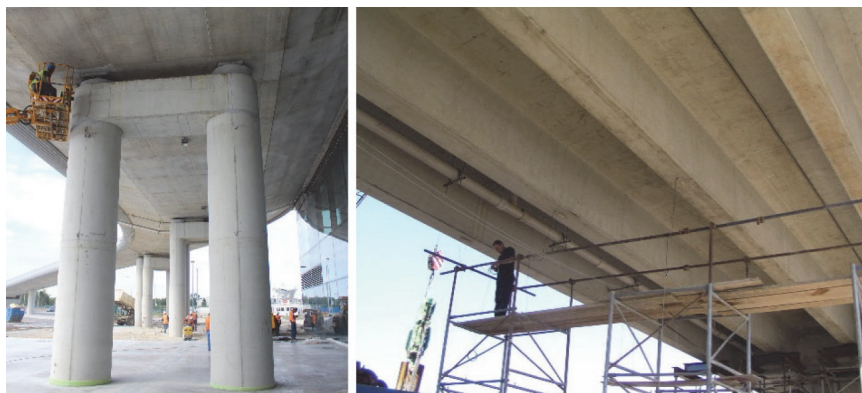
Slika 14. Postavljanje senzora s dizalice na vijaduktu u MZLZ i sa skele na nadvožnjaku Slavenska - Radnička u Zagrebu
