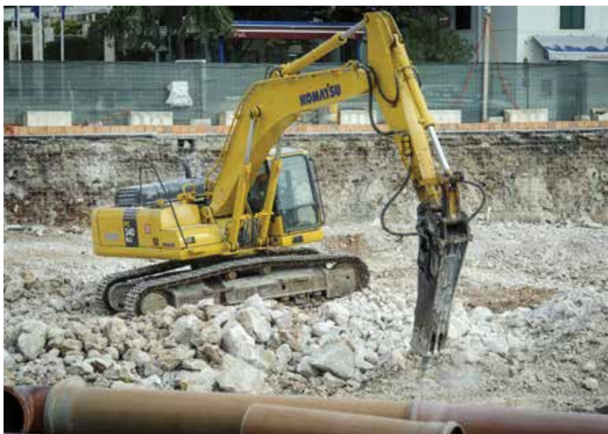
Rijeka je trenutno najveće gradilište u Hrvatskoj
