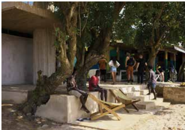
Pogled na terasu ispred prizemnice
