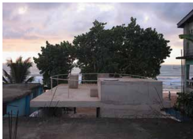
Nova krovna konstrukcija koja služi kao prostor za druženje
