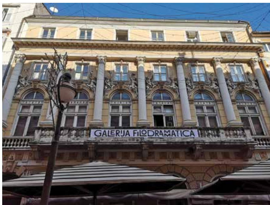
Pogled na povijesnu zgradu Filodrammatica na riječkom Korzu
