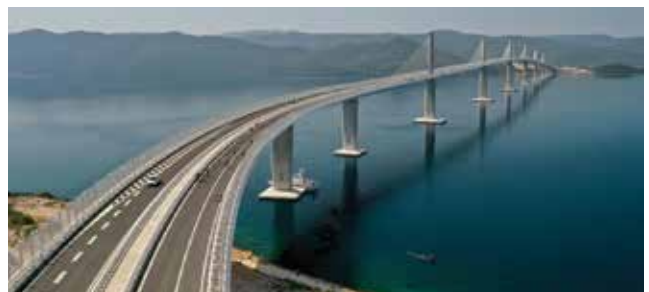
U okviru stručne ekskurzije DAGIT Slavonski Brod, inženjeri su posjetili gradilište Pelješkoga mosta
