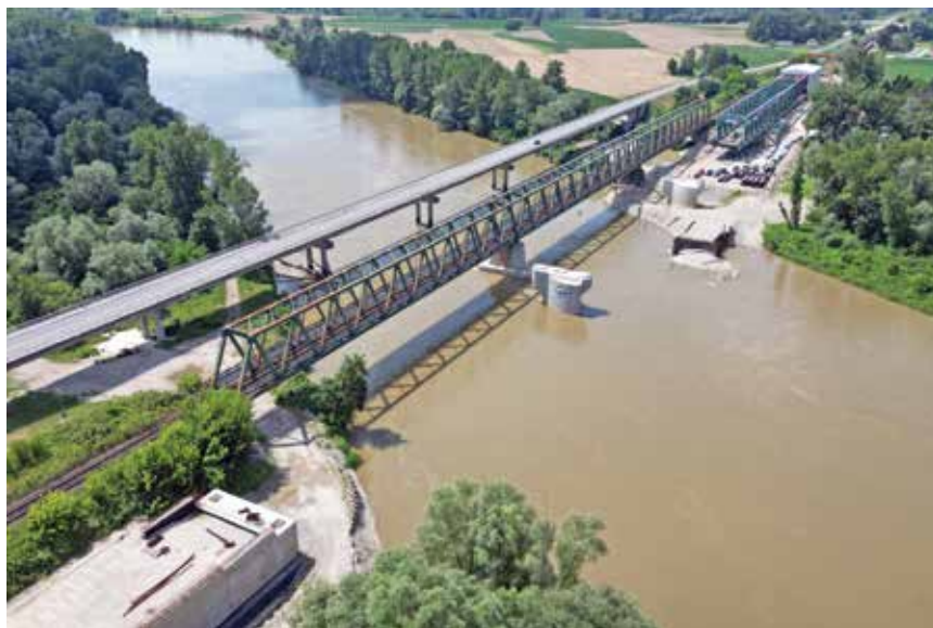
U tijeku je naguravanje novog mosta Drava
