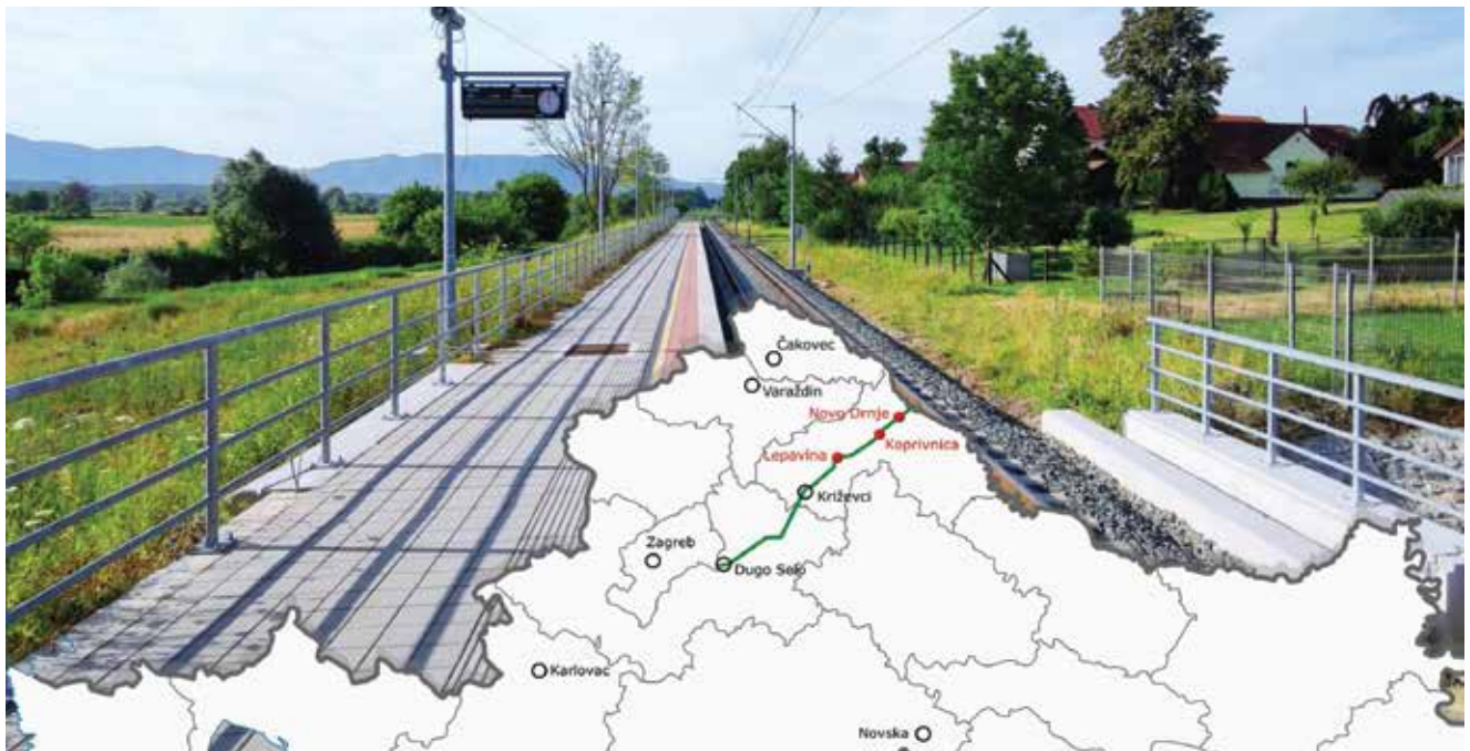
Rekonstrukcija dionice Križevci – Koprivnica – Državna granica najveće je infrastrukturno gradilište u Hrvatskoj
