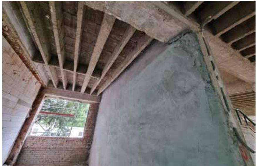
Izvedba novih AB zidova
