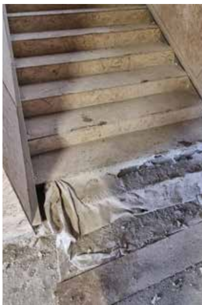
Projektom se zahtjevala zaštita postojećeg terrazza na stubištu
