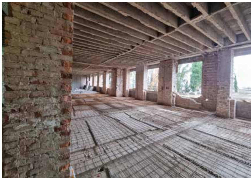
Ojačavanje postojećih zidova i stropova (lijevo) te izvedba AB radova (desno)
