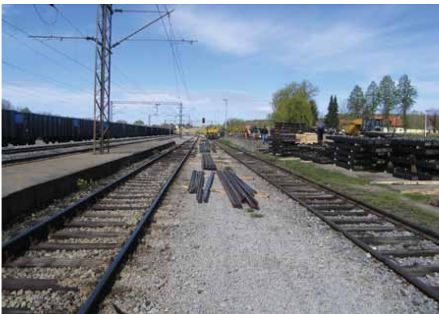
Pogled na gradilište u kolodvoru Lepavina
