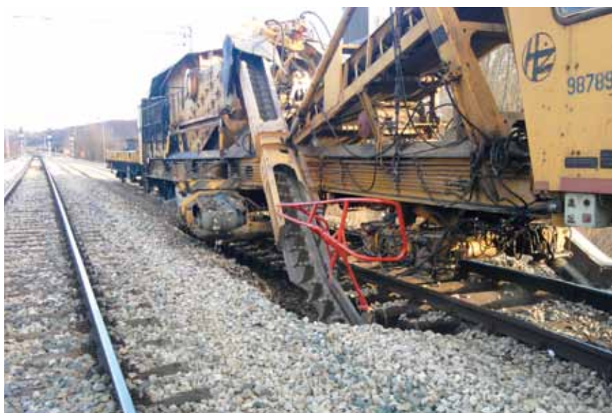
Strojni iskop starog tučenca
