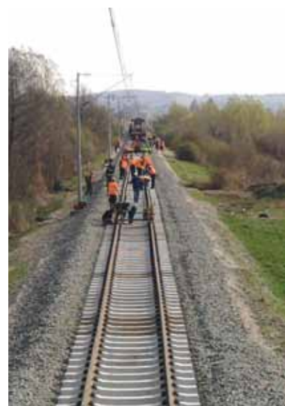
Ljudski je rad i danas nezamjenjiv u remontu
