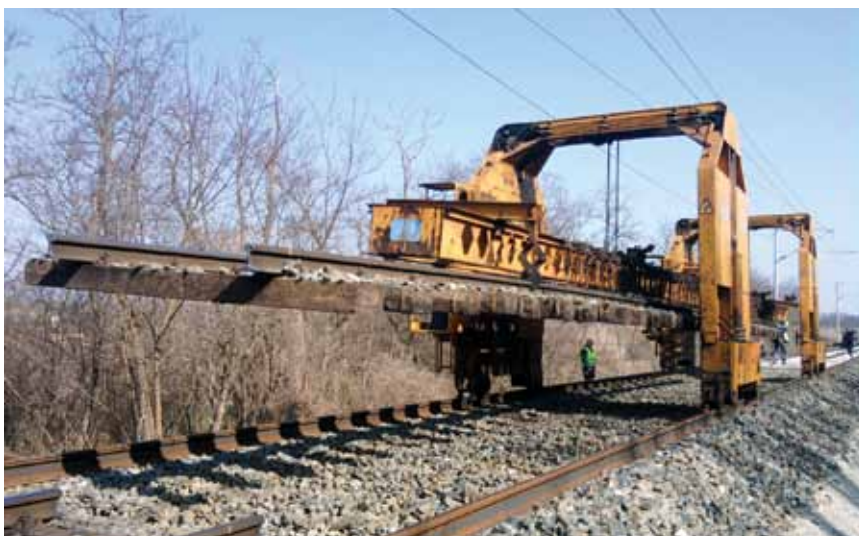
Strojna demontaža tračnica i pragova
