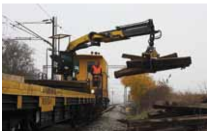
Odvoženje i odlaganje drvenih pragova
