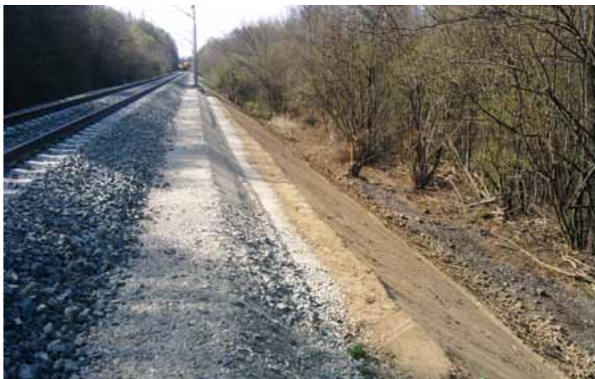
Dio pruge s obavljenim remontom
