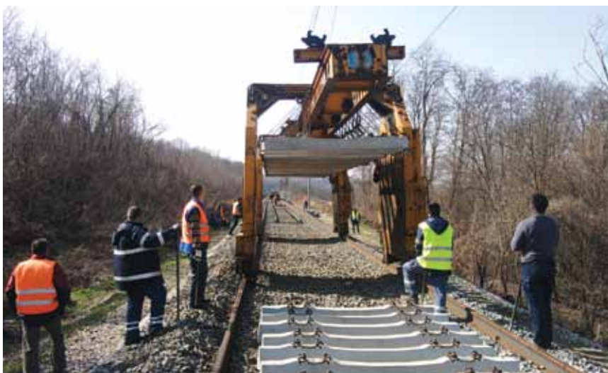
Ugradnja armiranobetonskih pragova
