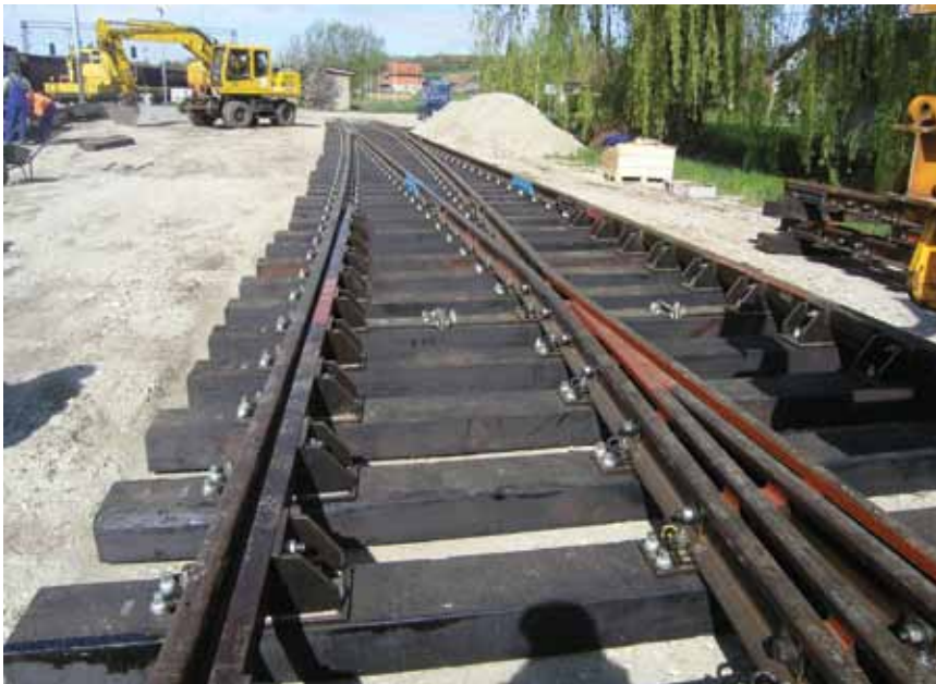
Prikaz ugradnje skretnice u kolodvoru Lepavina
