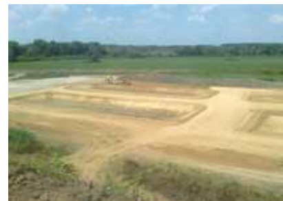
Zemljani radovi na gradilištu uređaja za pročišćavanje otpadnih voda u Iloku
