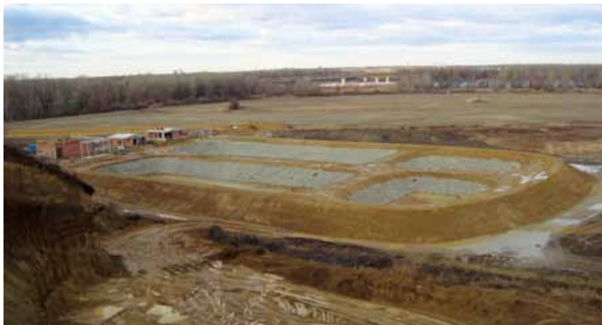
Pogled na gradilište s većim dijelom obavljenih radova (u pozadini cestovni most preko Dunava)
