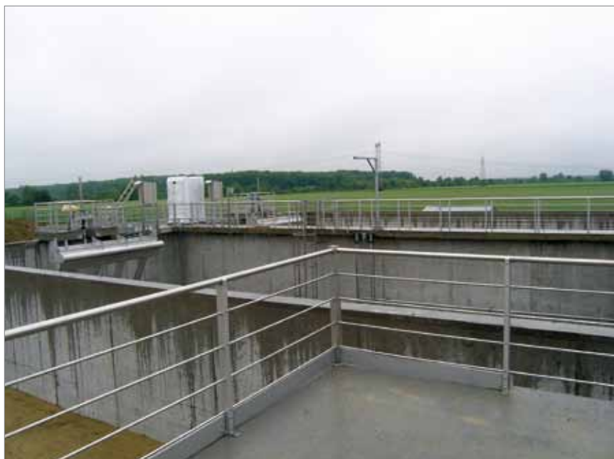
Detalj uređaja za pročišćavanje otpadnih voda u Cerni
