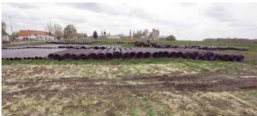
Cijevi za glavni kolektor i sekundarnu mrežu u Vukovaru
