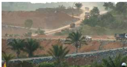
Započeli su i golemi zemljani radovi
