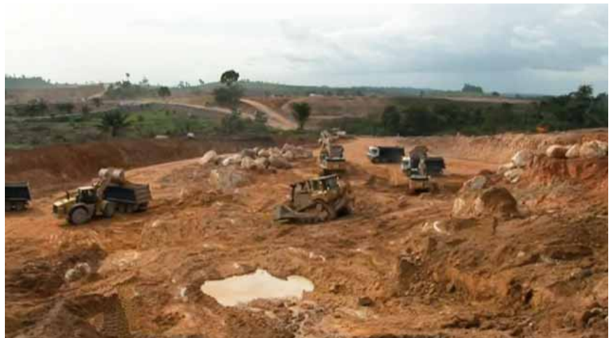
Detalj pripremnih radova za gradnju HE Belo Monte
