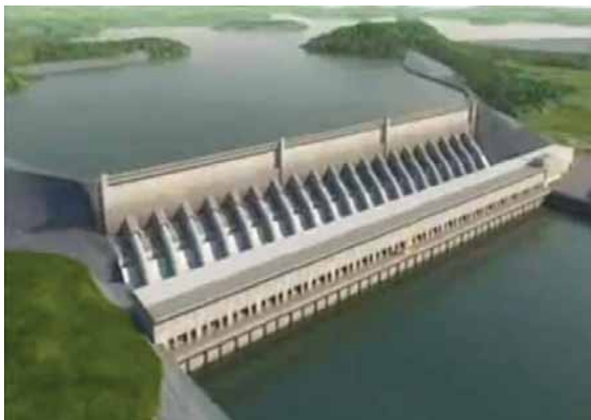
Brana i goleme cijevi što vode do strojarnice
