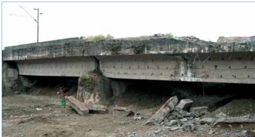
Sjeverni krak mosta pripremljen za miniranje
