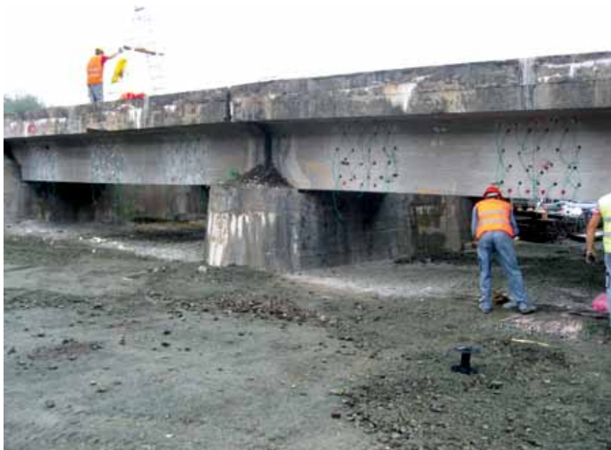
Južni krak mosta pripremljen za miniranje
