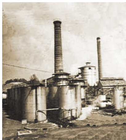
Dimnjaci jednog od prvih postrojenja za preradu nafte u Bosanskom Brodu
