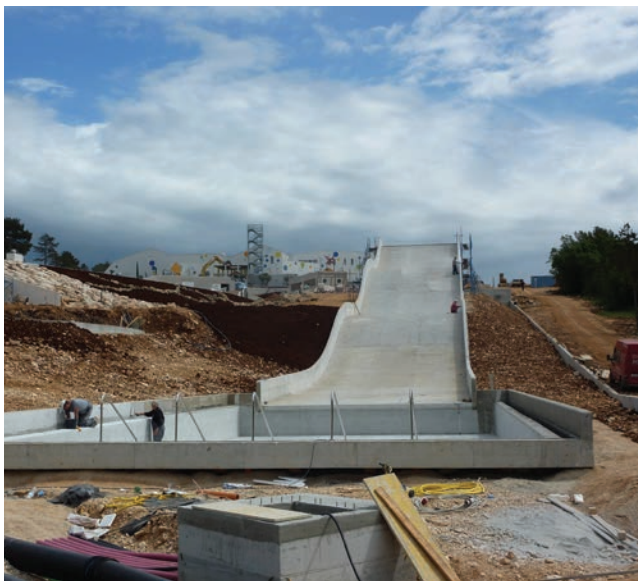
Betonska konstrukcija atrakcije nazvane "Crazy Hills"
