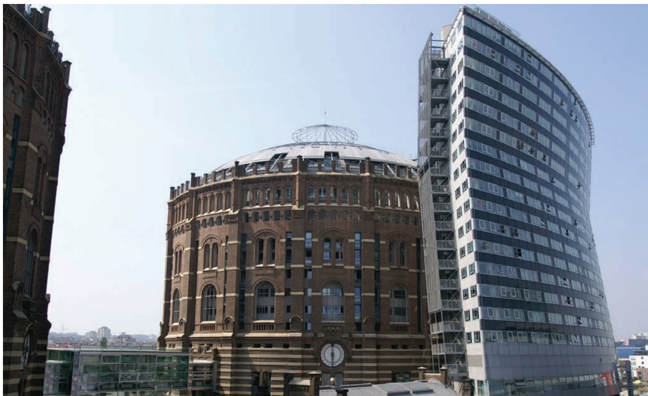
Građevina Gasometra B s nadogradnjom - zgradom u kojoj su stanovi i uredi
