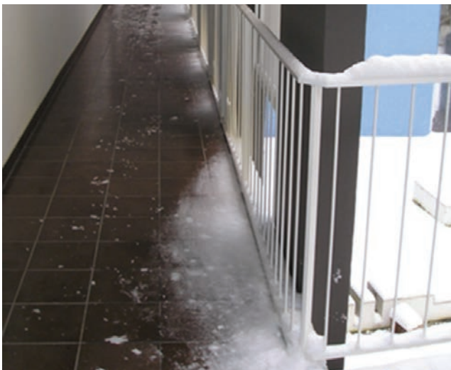
Slika 14. Nepravilno projektiranje galerije, Izvor: MGIPU, [5]
